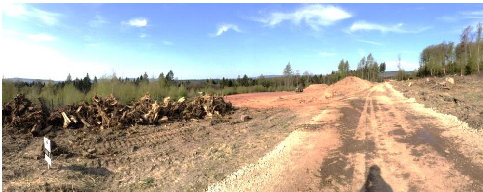
Abbildung 24: Windkraftbaustelle im Naturpark Kaufunger Wald (Hessen, 2016)
